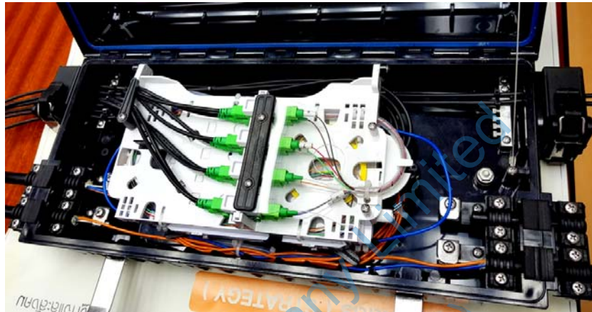
ภาพประกอบที่ 4. สาย OFTK ที่ใช้งาน ณ ตำแหน่งตู้ SDP/ODP
