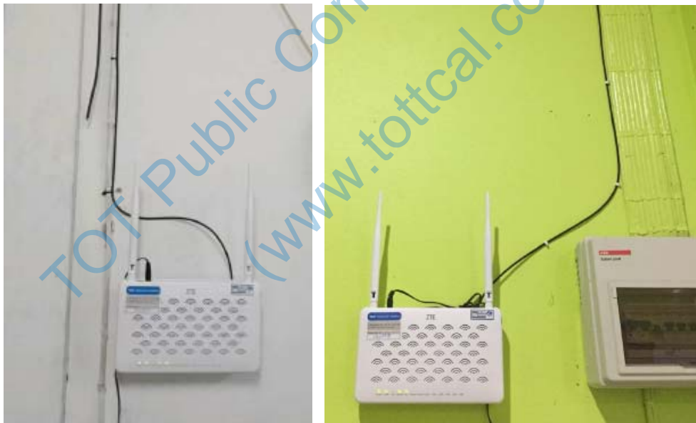
ภาพประกอบที่ 4. สาย OFTK ที่ใช้งาน ณ ตำแหน่ง ONU/ONT
